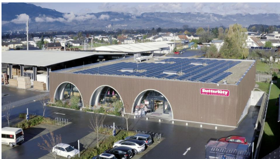
Bildunterschrift: Sutterlüty Ländlemarkt Rankweil-Landamann-gasse mit PV-Anlagen Bildnachweis: Christian Kerber (©Sutterlüty)
